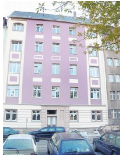
Dieser Eigentümer an der Eilenburger Straße in Dresden hat seine Hausaufgaben schon gemacht: Das Gebäude wurde energetisch saniert. Foto: Sylvia Redlich
